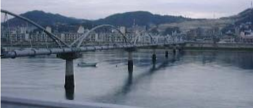
水管橋 [水門+6130m/1090m+艇庫]。
