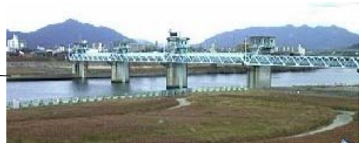
祇園水門 [7220m+艇庫] :放水路の最上流.
