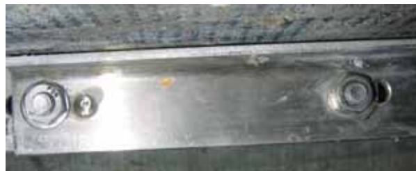
組み立てたフレームはデッキに密着。(軽量艇ではスペーサー必要)
